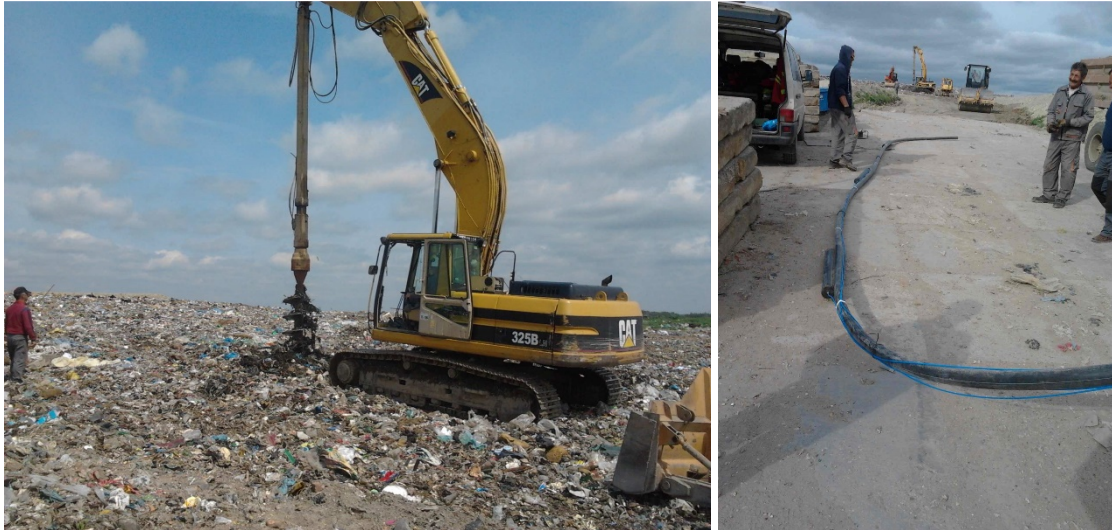
5.1. ábra: A furatok kialakítása a depóniatestben és az elkészült hőmérséklet-eloszlás mérő szonda
