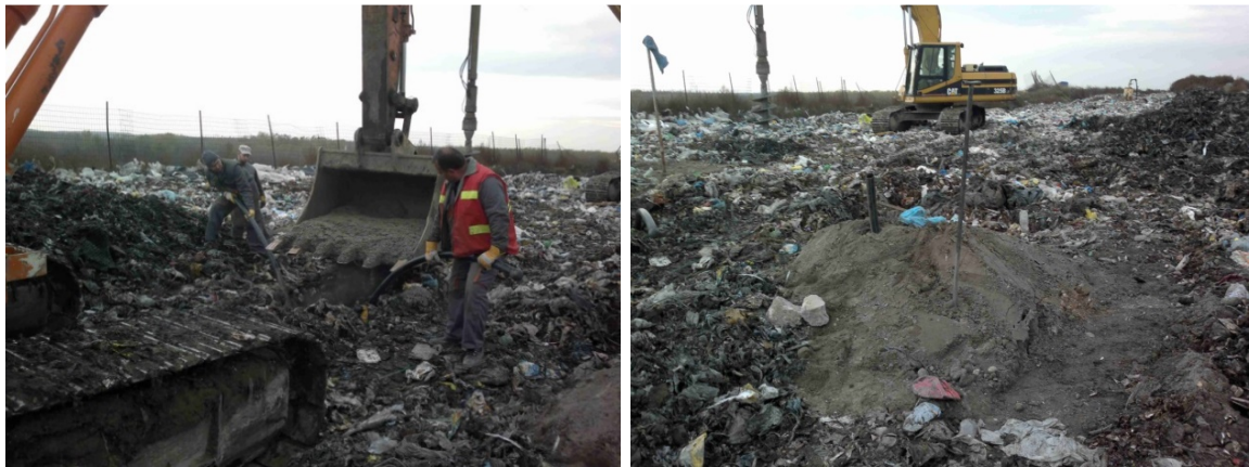
5.9. ábra: A függőleges kutak kialakítása és feltöltése
