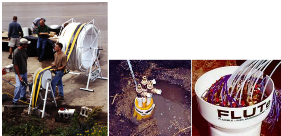
17. ábra A FLUTE rendszer telepítés közben, és a kész kútfejek a felszínen (Internet_6).
